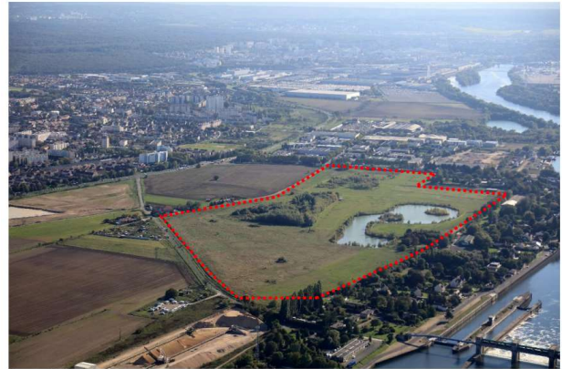
Vue aérienne du site prise depuis le Nord Est
